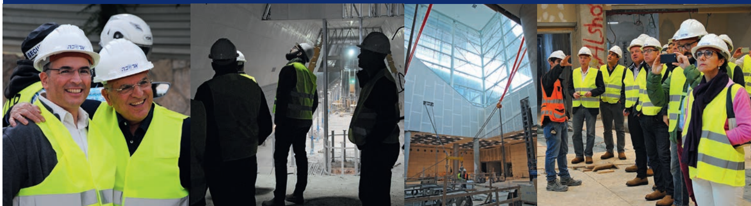
La stazione ferroviaria «HaUma» è situata 80 metri sotto le strade di Gerusalemme ed è attualmente il più grande cantiere di Israele.
